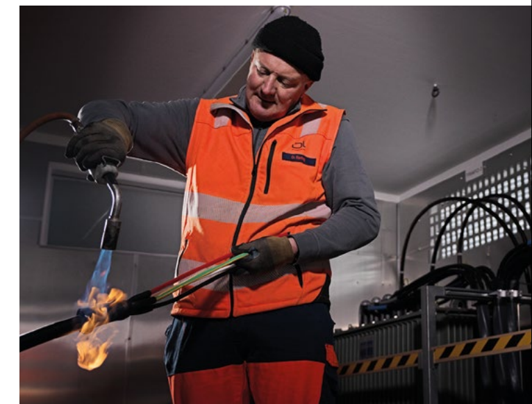
Netzmonteur Strom wie Daniel Spring, bauen, warten und reparieren grosse Kabelanlagen und Transformatoren, um die Energieversorgung sicherzustellen.
