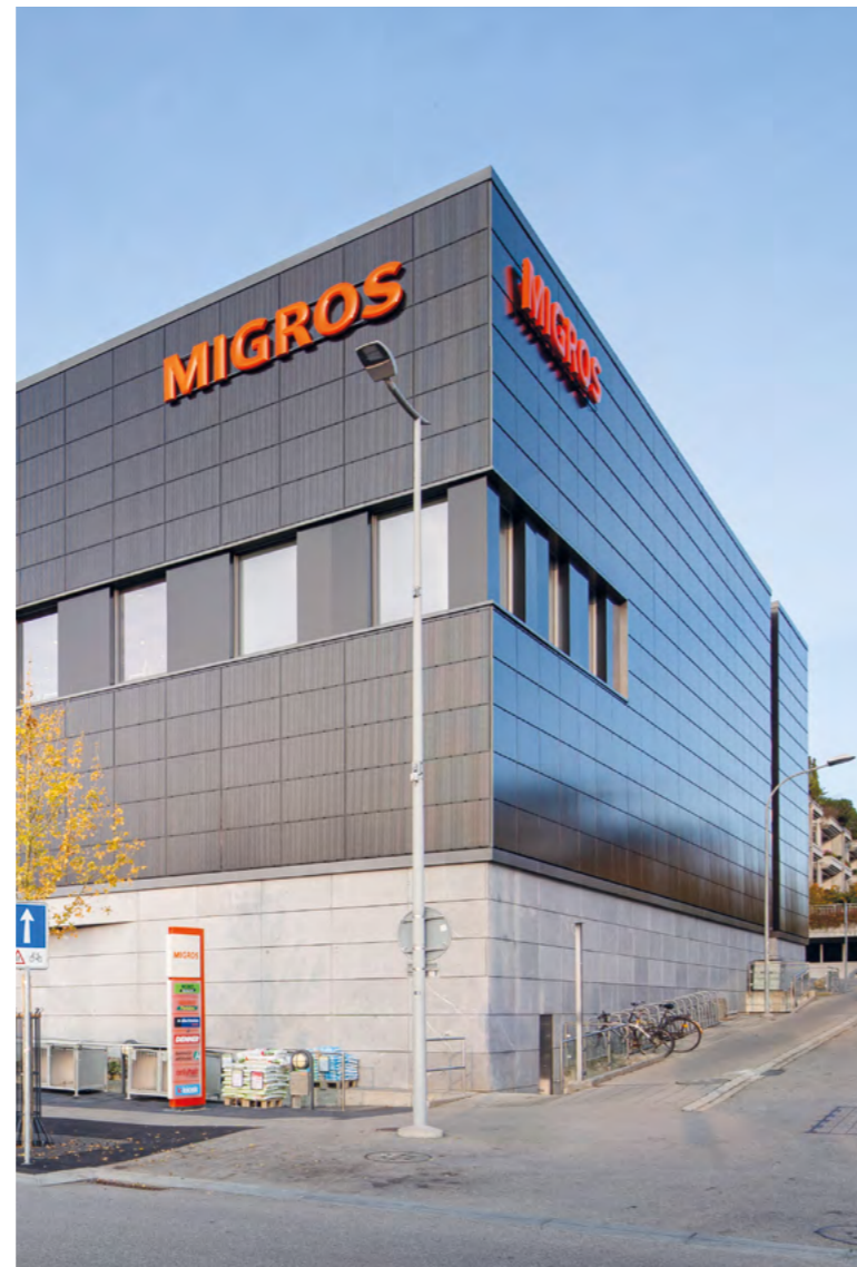
Die Photovoltaik Fassade an der Migros-Filiale in Münsingen BE hat eine Leistung von 218 kW.
